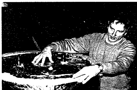
Pokrijte gornji dio spremnika kamenom vunom
